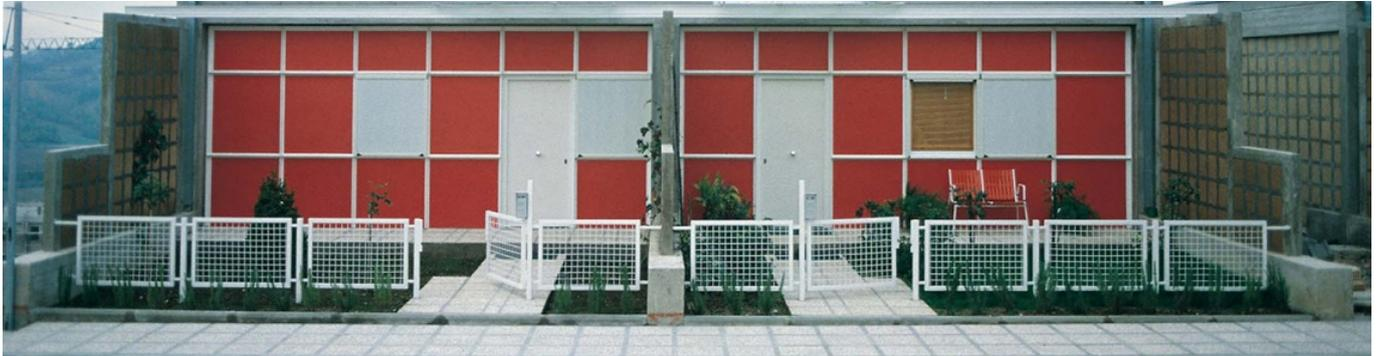
Moduli abitativi standard di 6 metri di larghezza per 6 metri di altezza, con la possibilità di una superficie calpestabile che varia da 50 a 120 metri quadri. La combinazione tra uno spazio primario esterno, prodotto industrialmente, e uno secondario interno, lasciato agli utilizzatori.
