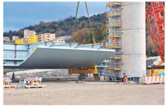
Sequenza di varo e completamento in quota di una campata da 50 m
