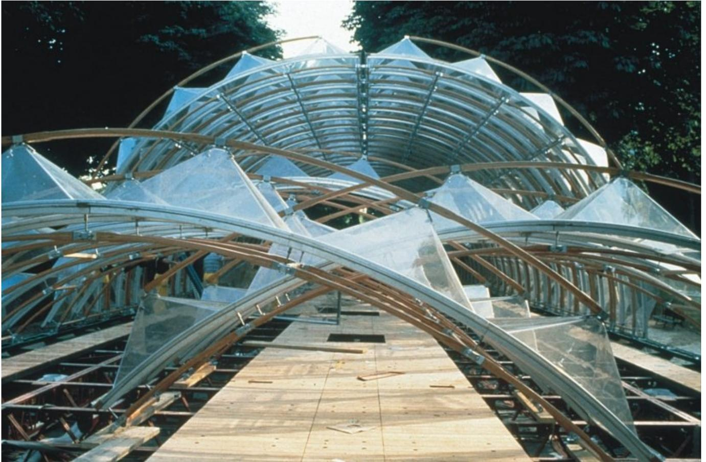
La mostra itinerante IBM nacque per presentare in venti città d'Europa le trasformazioni del futuro tecnologico. I materiali impiegati furono legno lamellare per le aste di collegamento, pezzi in fusione di alluminio per i giunti, policarbonato per gli elementi di copertura a forma piramidale. Questi componenti erano autoportanti e, collegati tra loro, costituivano l'arco strutturale del padiglione.
